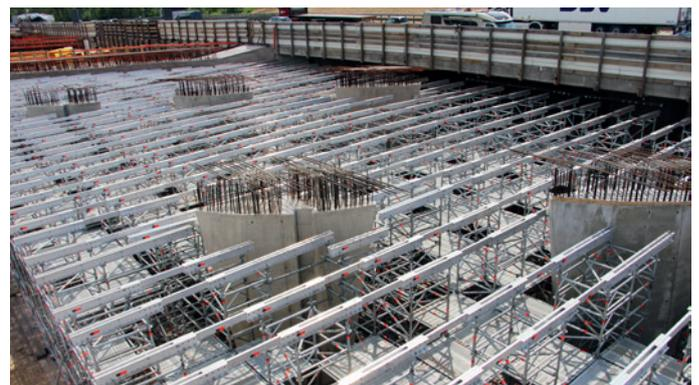
Fertig montiertes und eingemessenes Traggerüst
